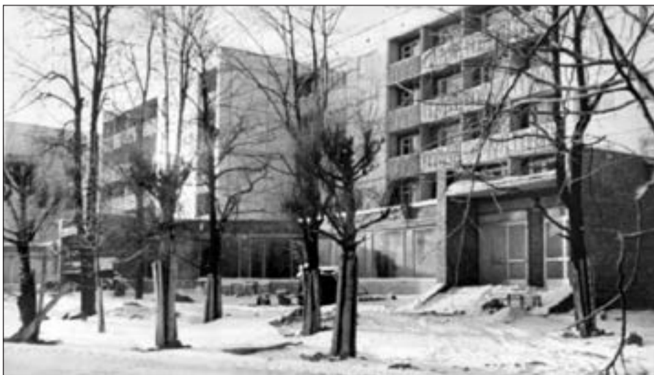
Строительство дома по адресу ул. К.Маркса, 4. 1983 г. Фото из книги «ОАО «Завод «Буревестник» - 90 лет развития 1924-2014»
